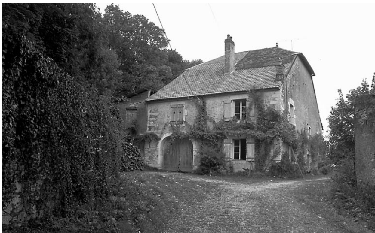
Avrigny-Virey : ferme située rue de l'Eglise.
