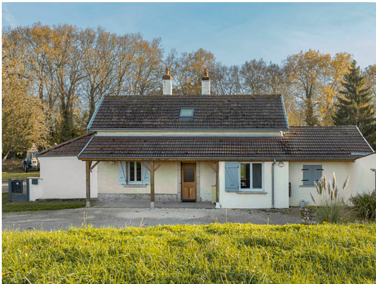
Vue de face de la maison.
