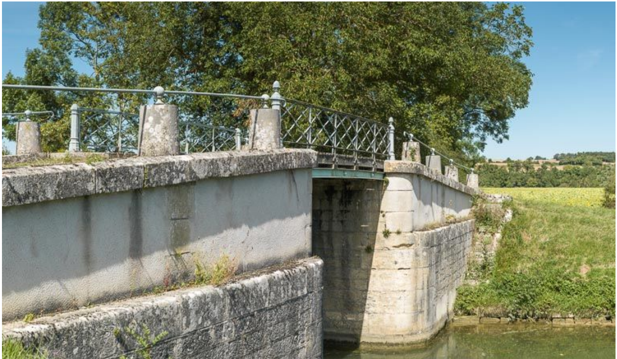
Le pont, pris d'aval.
