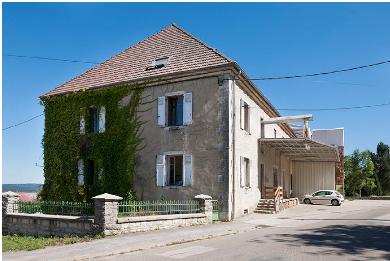
Extrémité sud du bâtiment : bureaux et logements.
