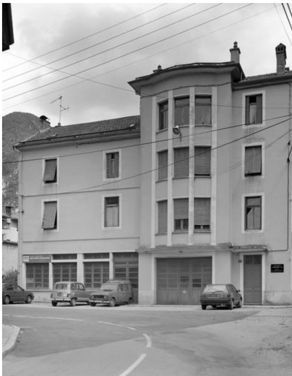
Extrémité nord de la façade antérieure.
