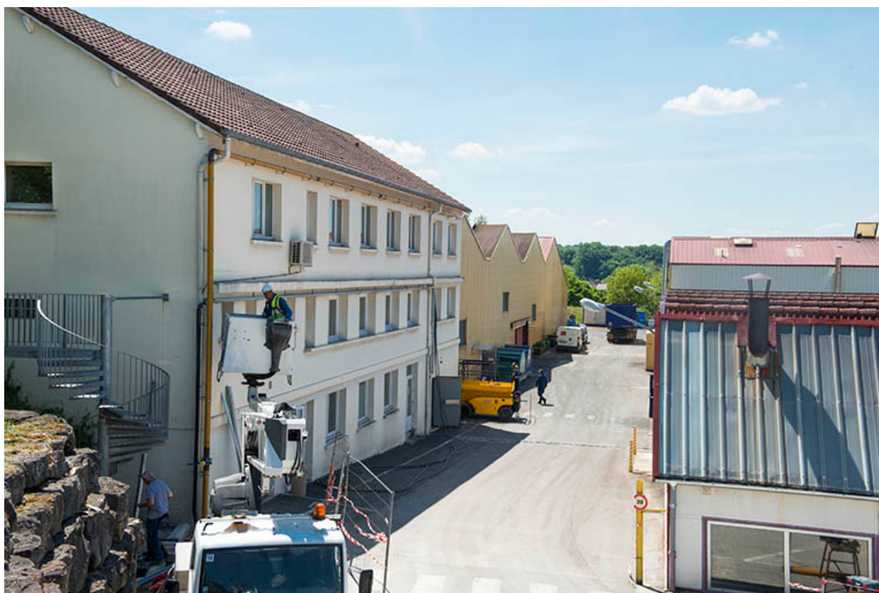
Bâtiment administratif et atelier de fabrication.
