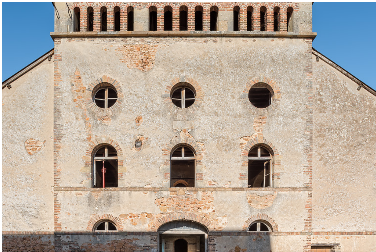
Baies du deuxième et du troisième niveau.
