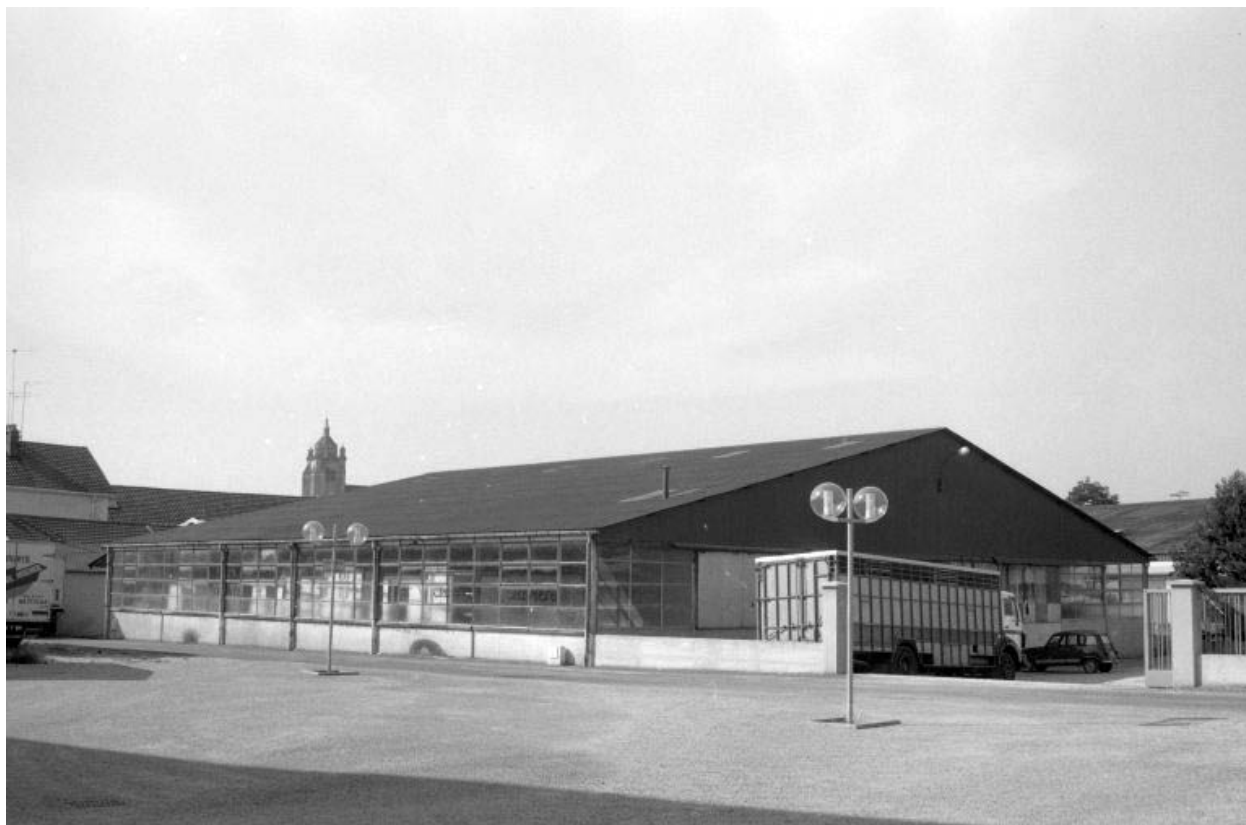
Remise (ancienne usine U.M.D.).
