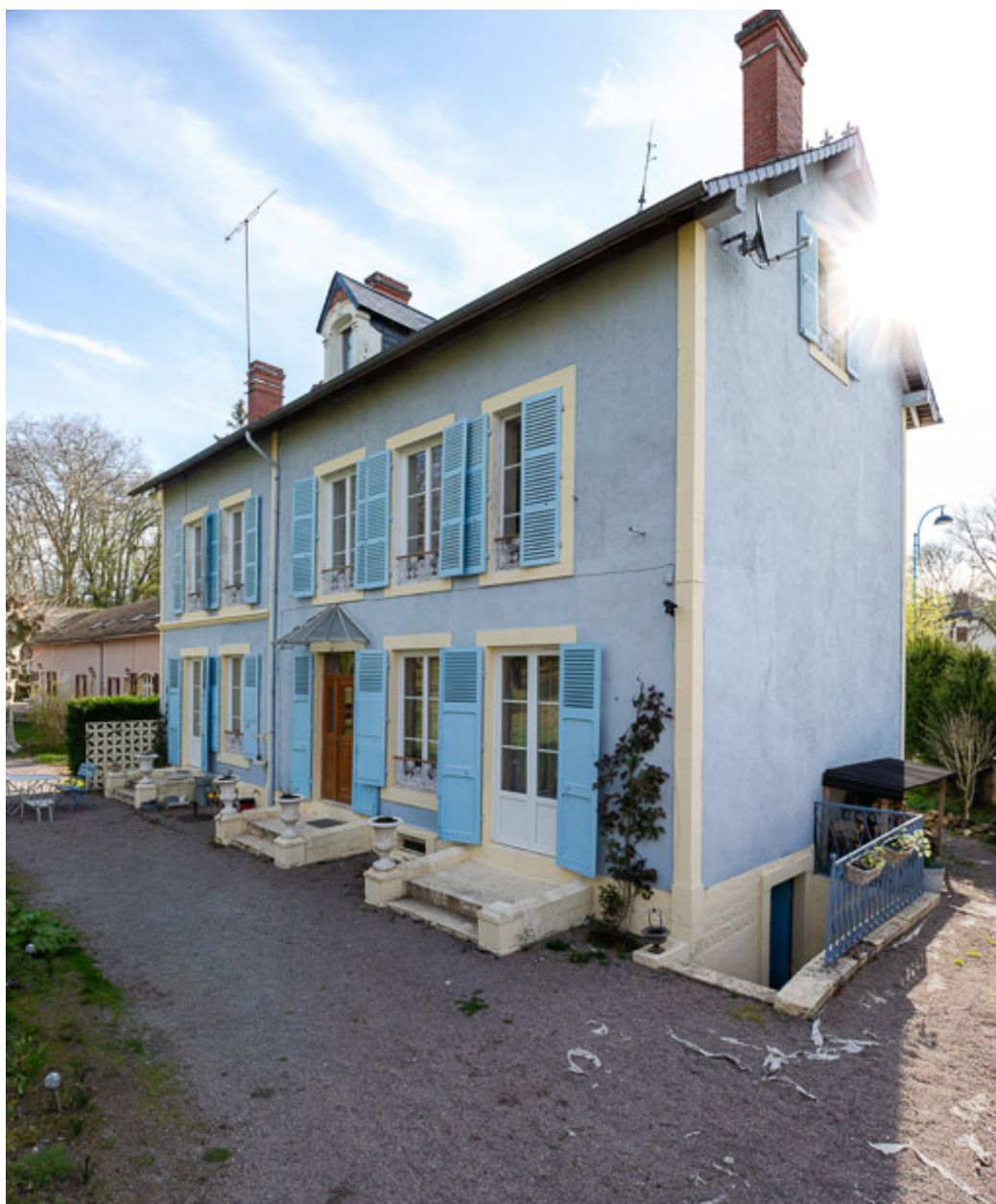
Façade nord-ouest et pignon sud-ouest.
