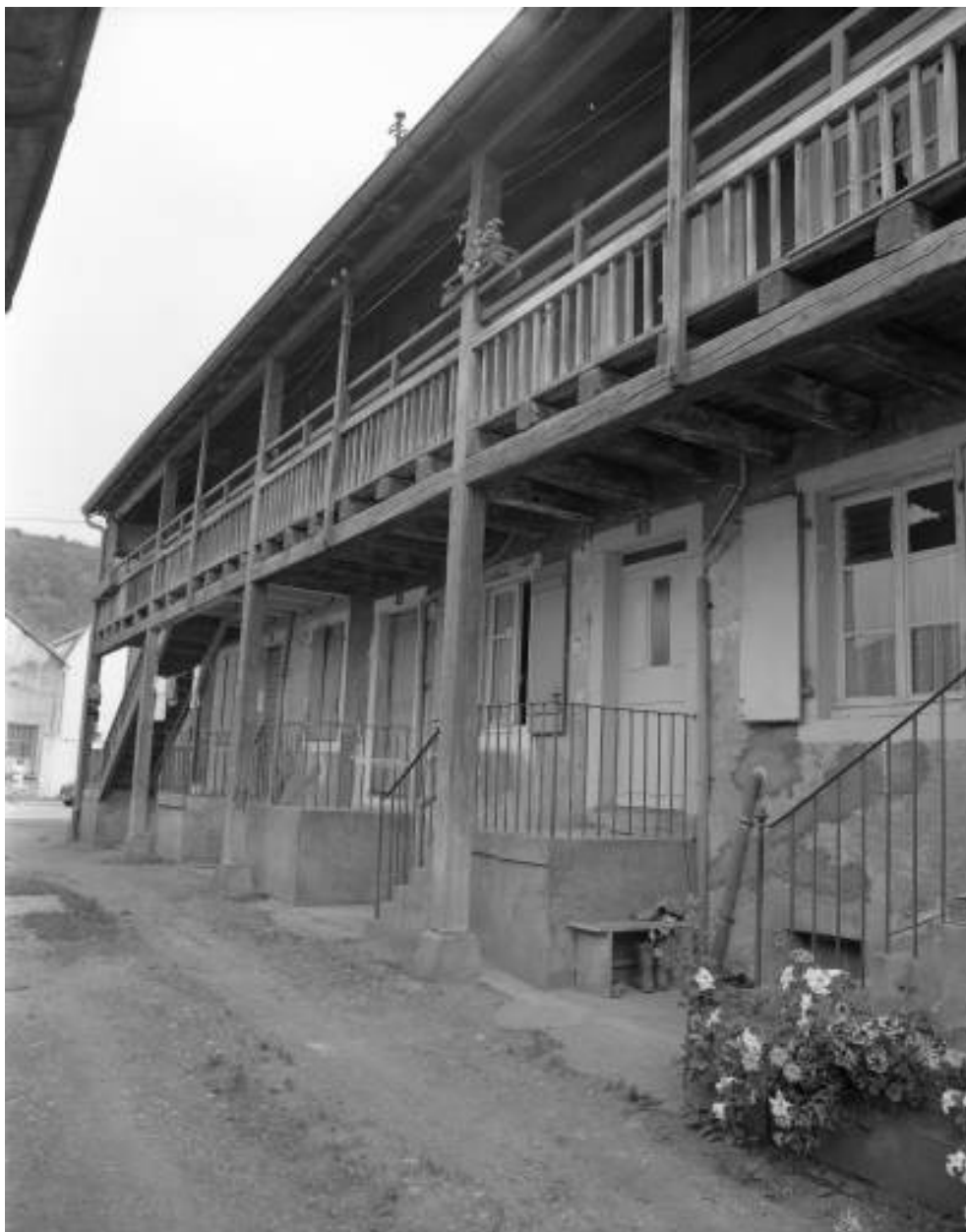
Façade nord et galerie en bois en 1981.
