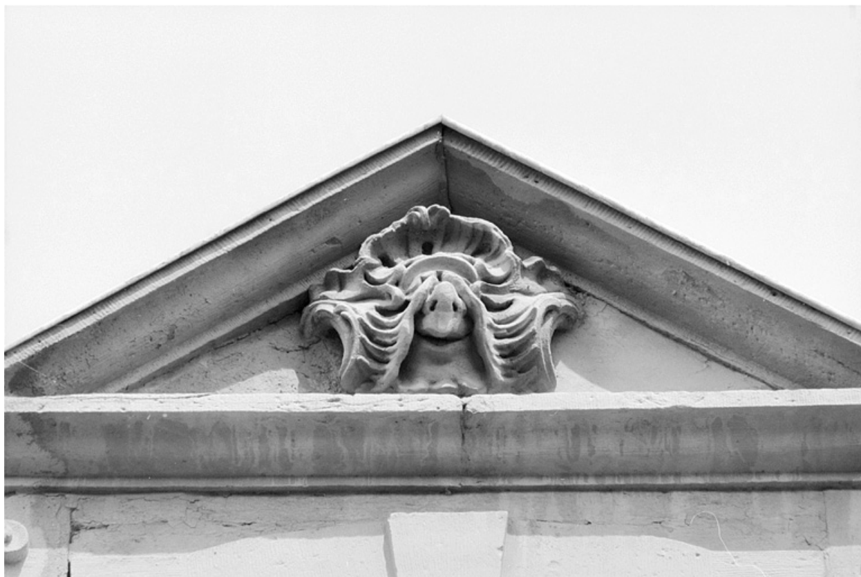
Façade principale, détail de la grande lucarne.
