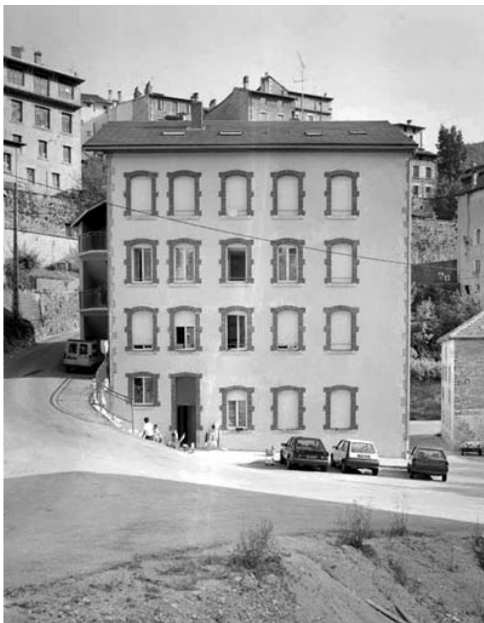
Immeuble (ancienne maison Vuillard) : façade antérieure.
