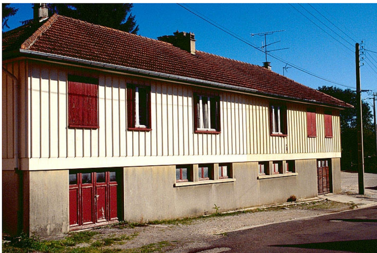
Logement double à étage (maison Fillod).
