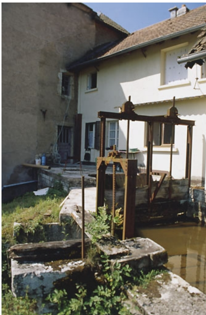
Vannage sur le canal d'amenée.
