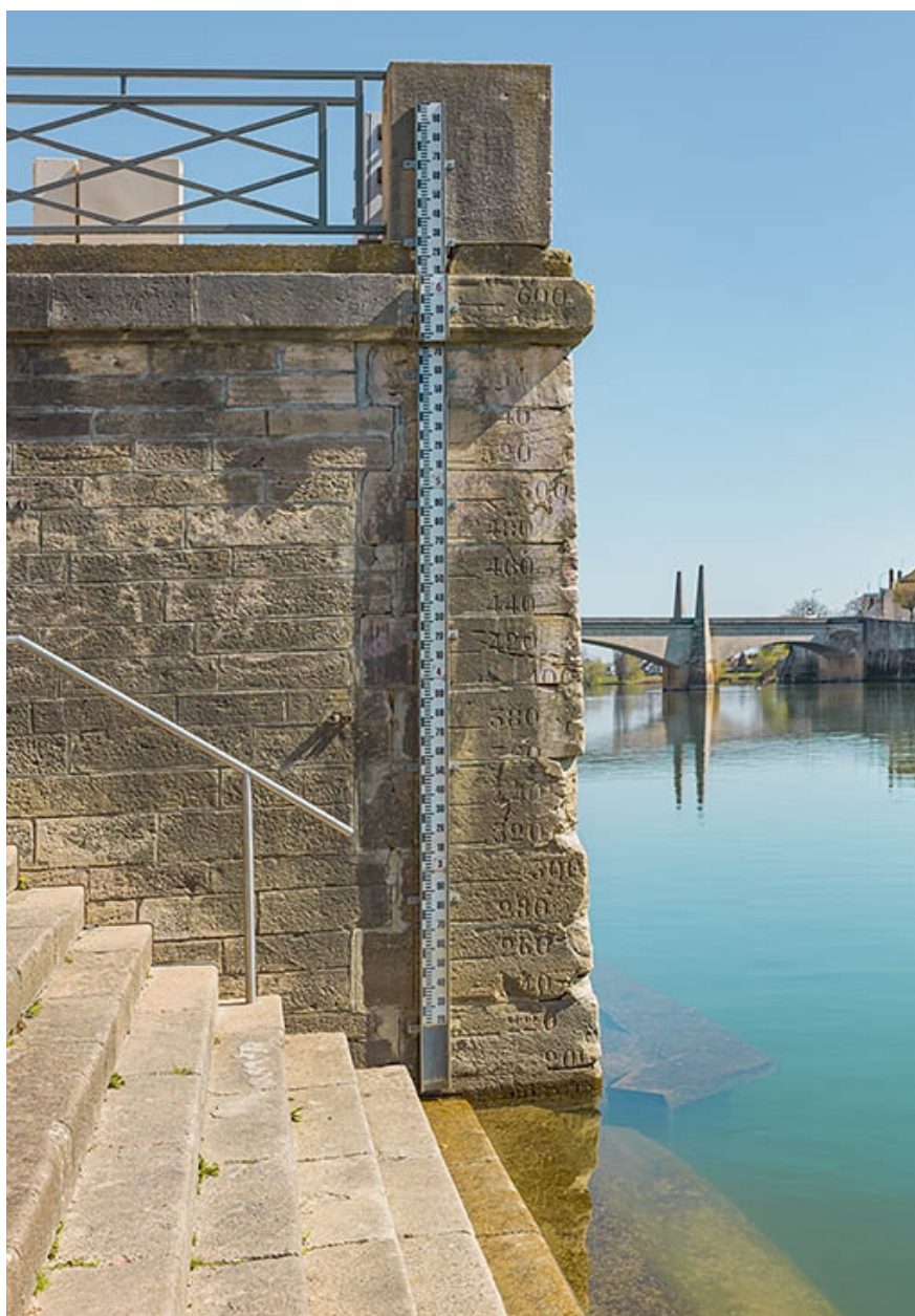
L'échelle de crue historique du port Villiers.
