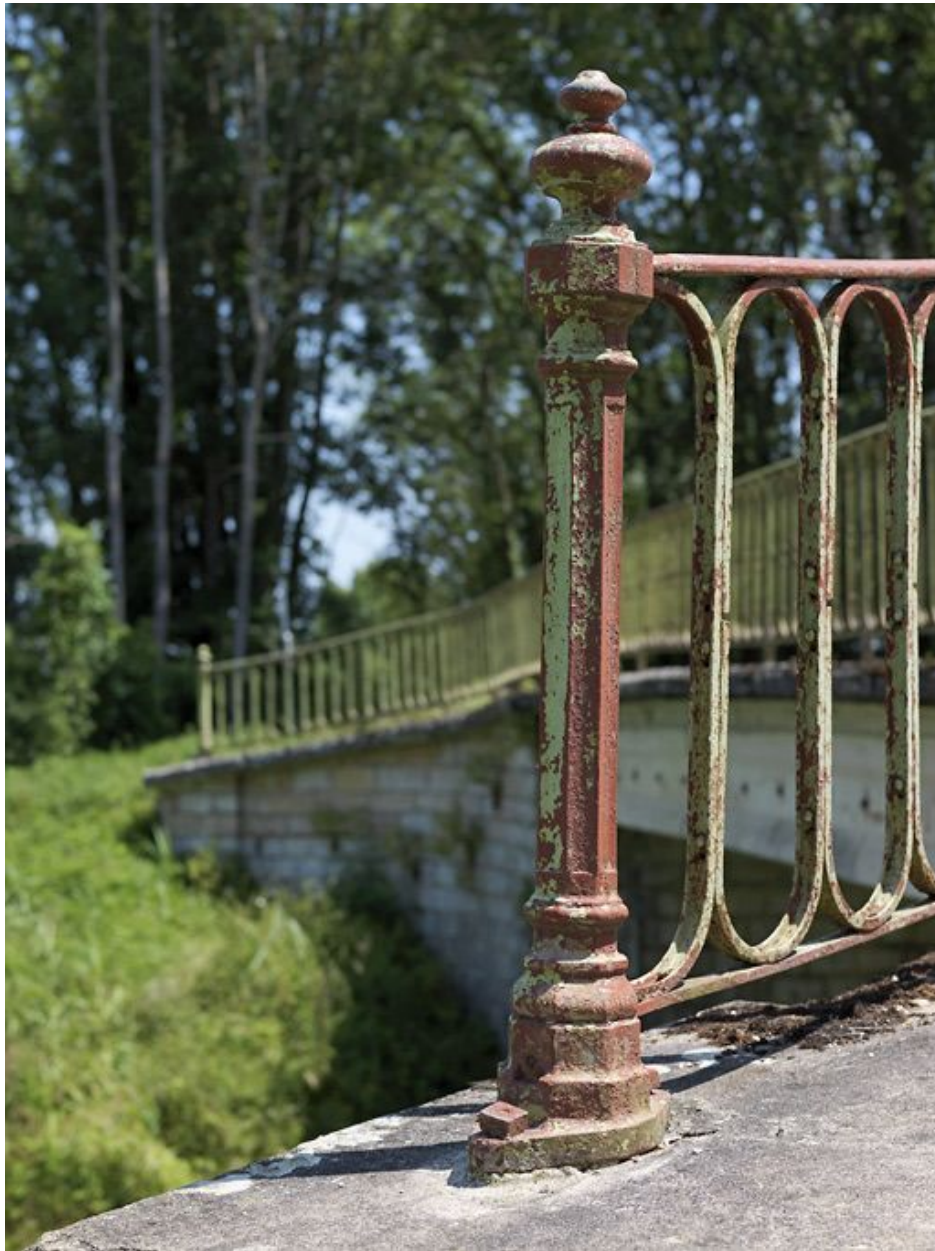
Détail du garde-corps en métal.
