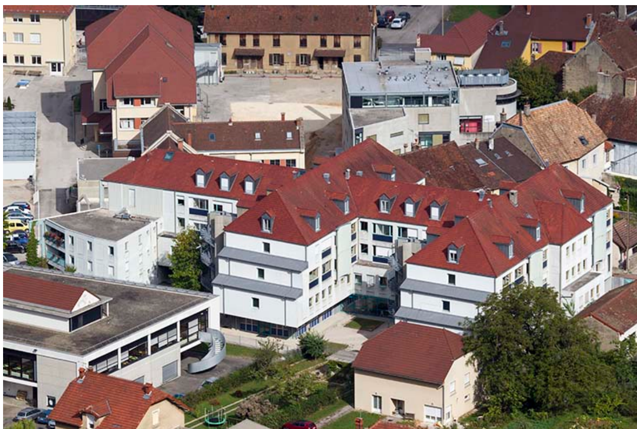
Internat : vue générale.
