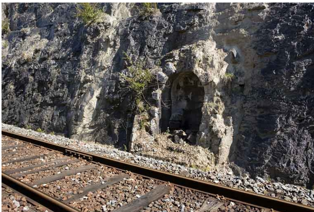
Premier abri (à gauche de la voie).
