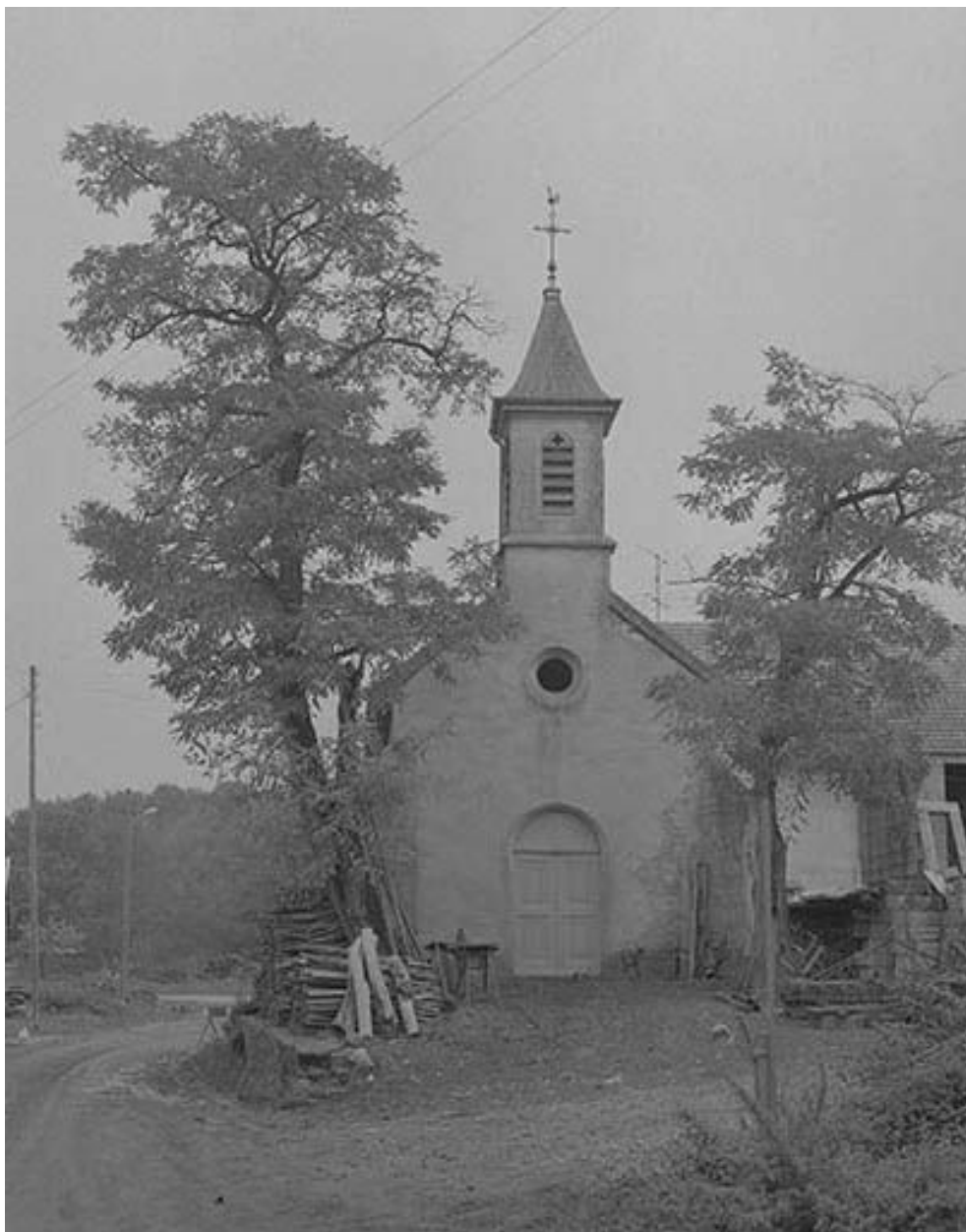
Extérieur : façade antérieure.
