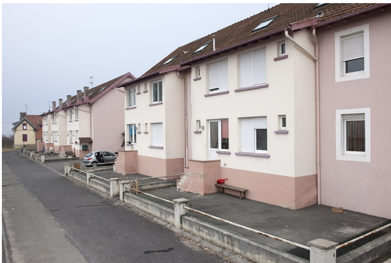
Immeubles d'habitation vus depuis l'est.
