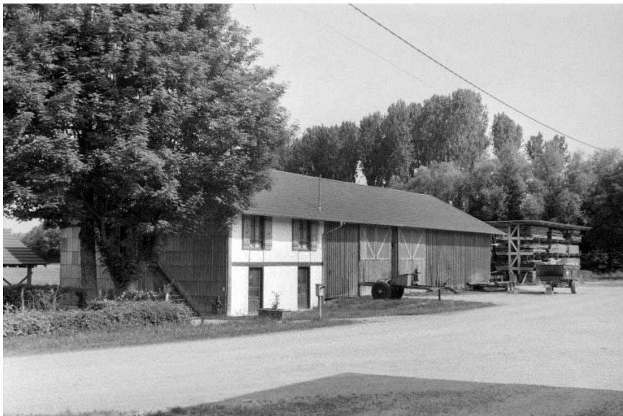
Magasin industriel (M) et logement d'ouvriers (N).
