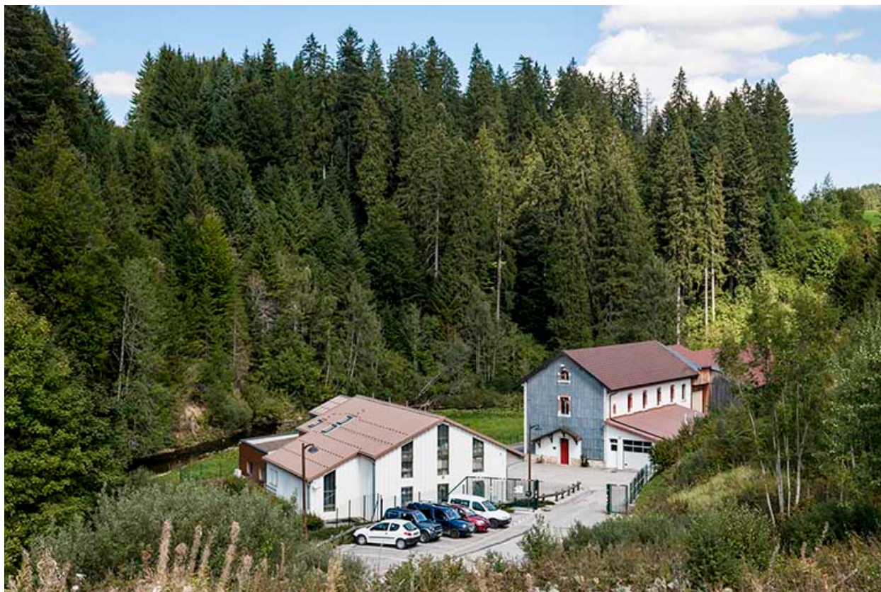
Centrale du Fourpéret, Labergement-Sainte-Marie.
