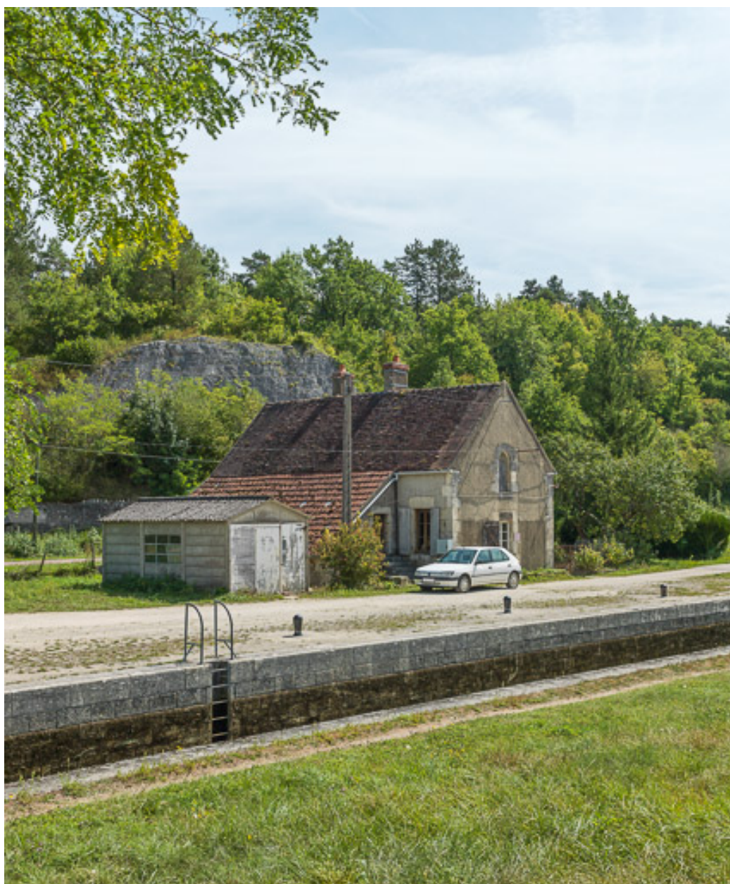
Vue de la maison éclusière.
