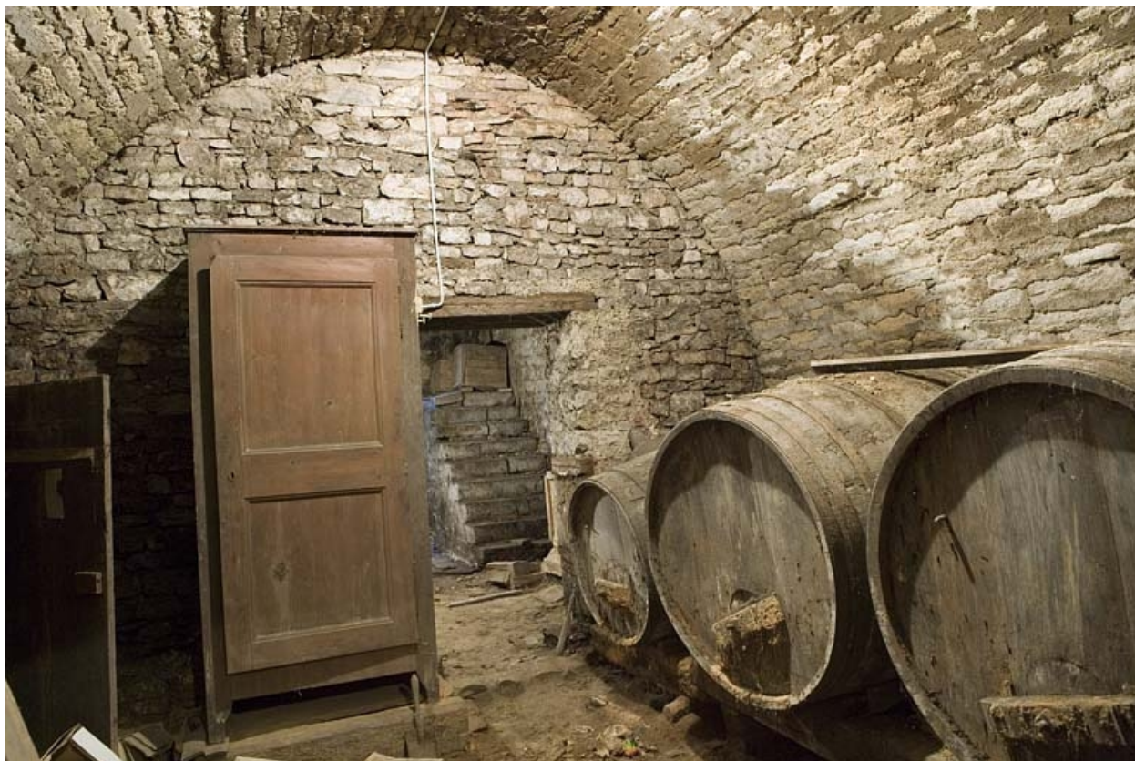
Intérieur, sous-sol : cave droite, partie médiane.
