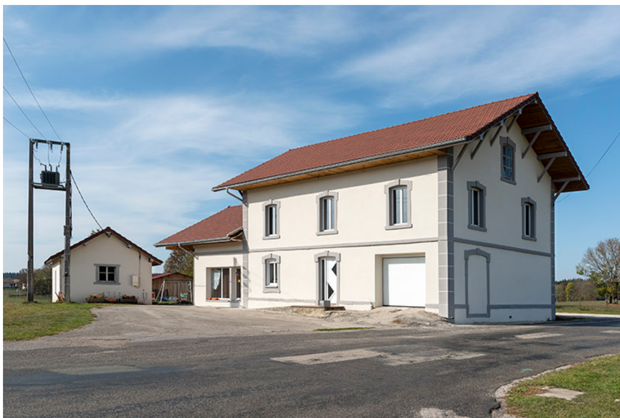
Fromagerie : façades antérieure et latérale droite.
