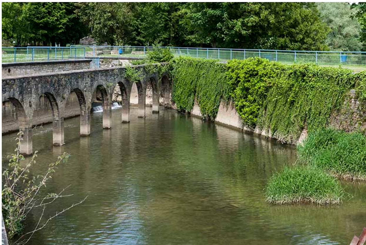
L'ancien canal de fuite.
