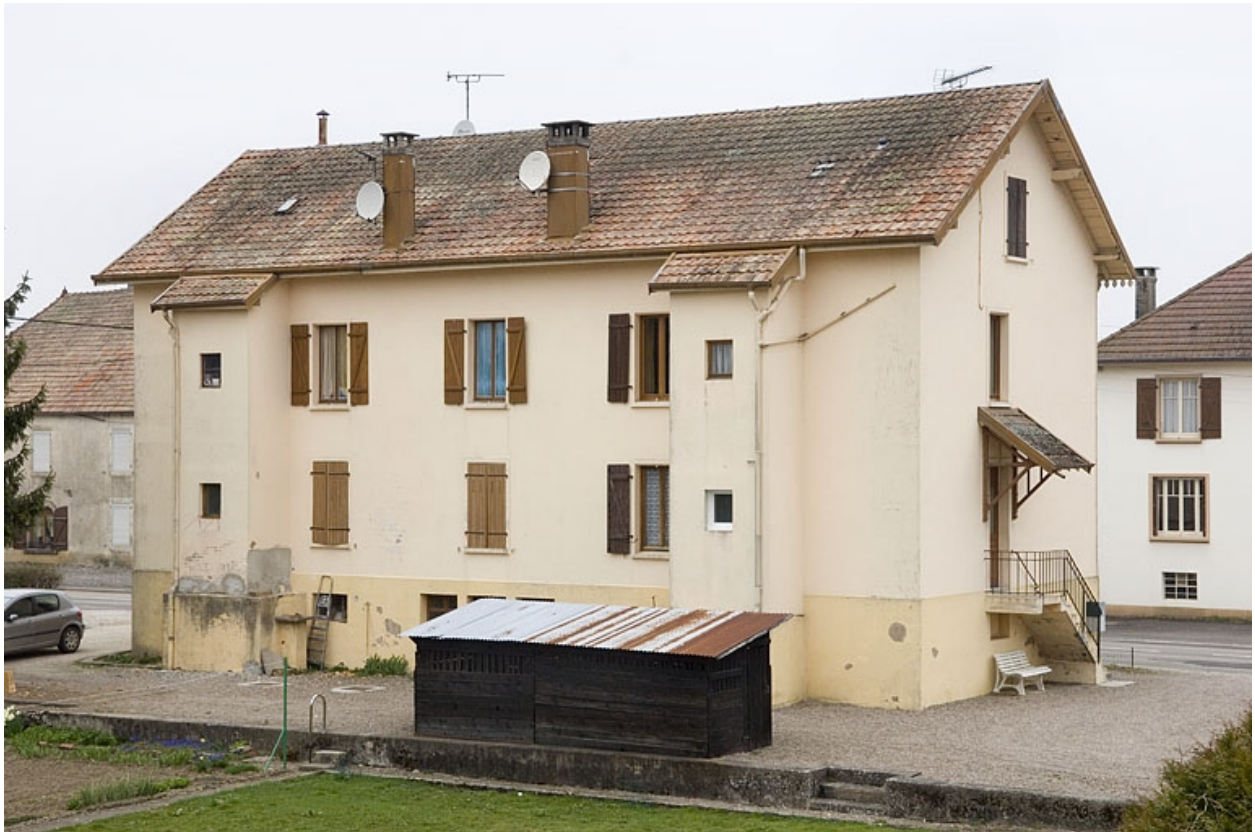
Façade postérieure d'une maison ouvrière.
