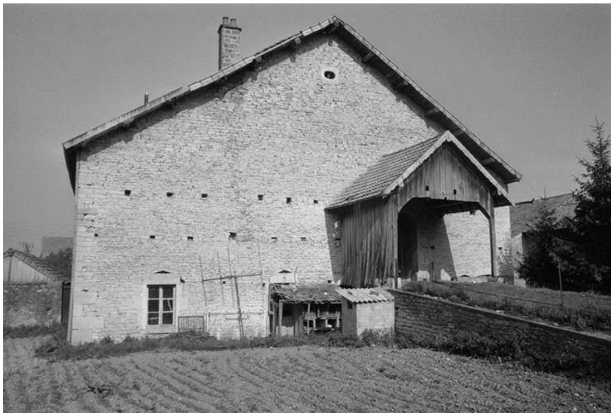
Ferme située 2 rue de Tarcenay.
