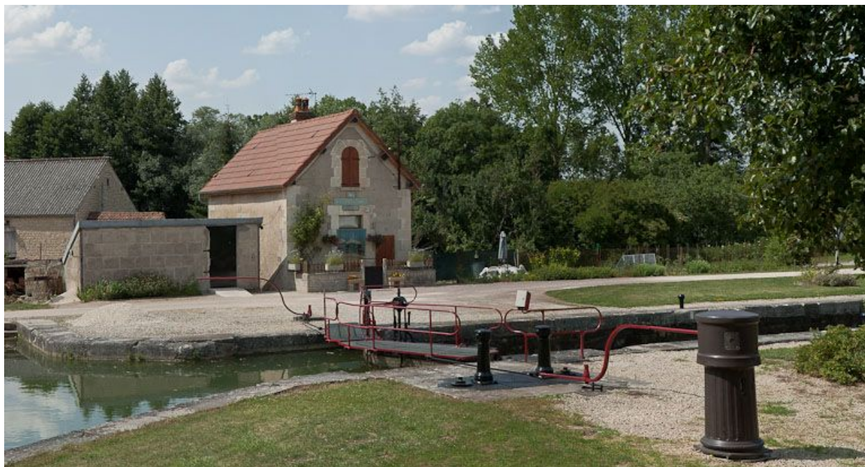
Vue d'ensemble du site d'écluse.
