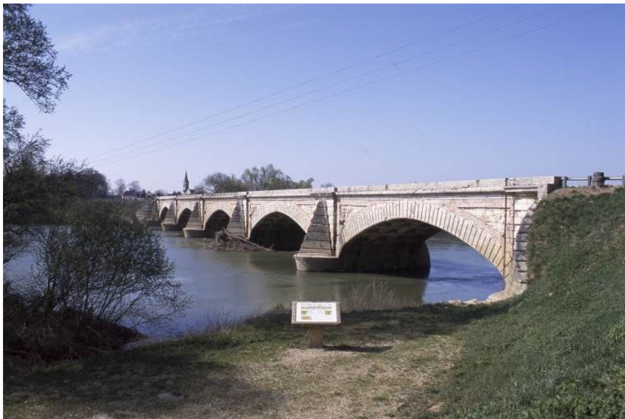
Vue d'ensemble en amont.
