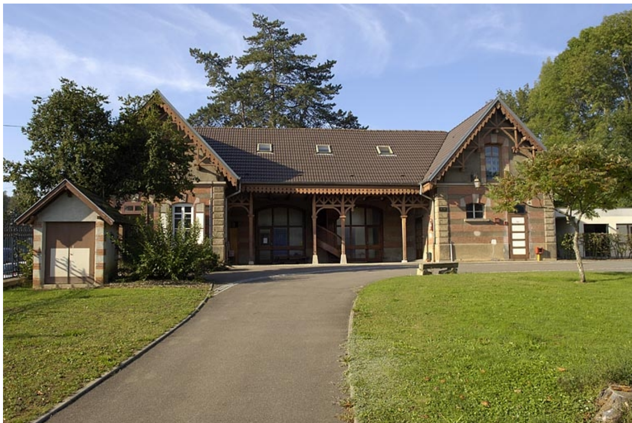
Façade nord de l'ancienne écurie (?).
