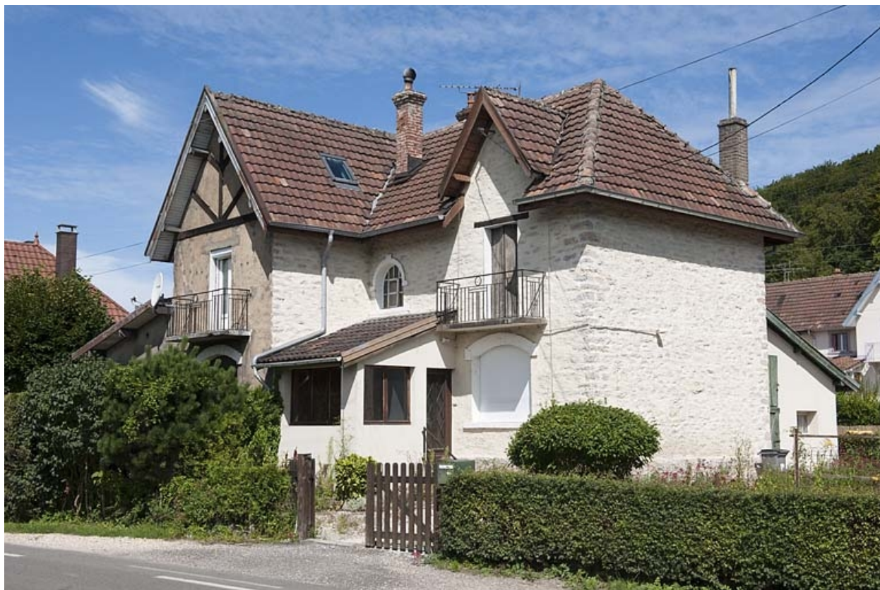
Maison de contremaîtres vue de trois quarts.
