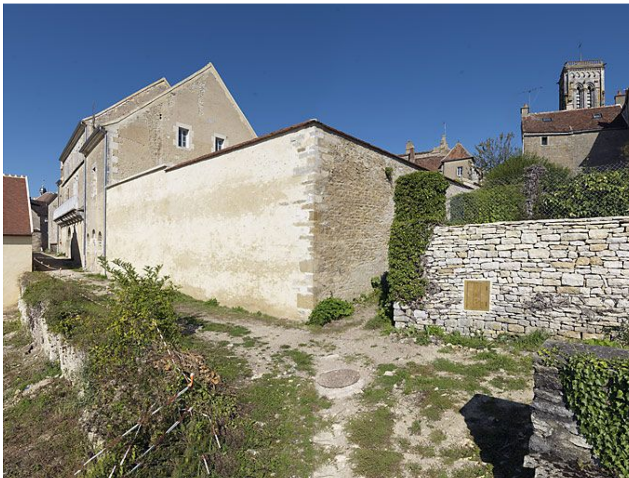
Vue d'ensemble prise du sud-est.
