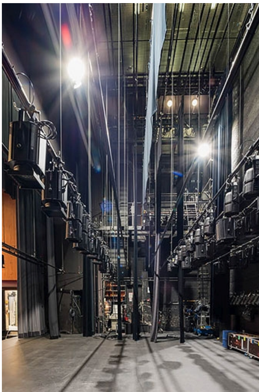
Cage de scène : perches avec projecteurs (vue latérale).
