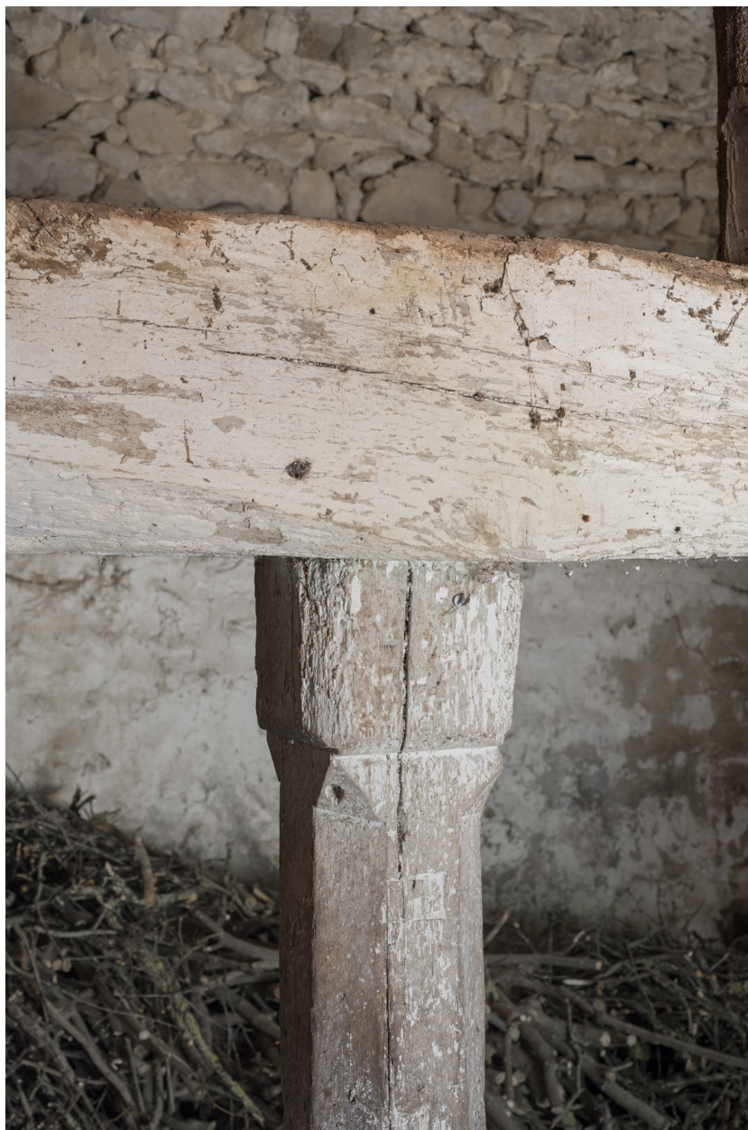
Vue rapprochée d'un assemblage poutre-poteau.
