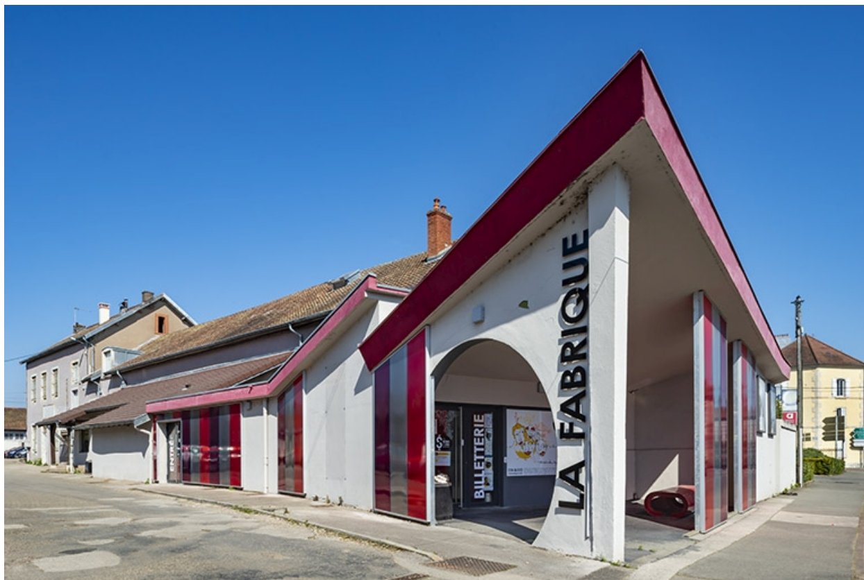
Façade latérale gauche, de trois quarts droite.
