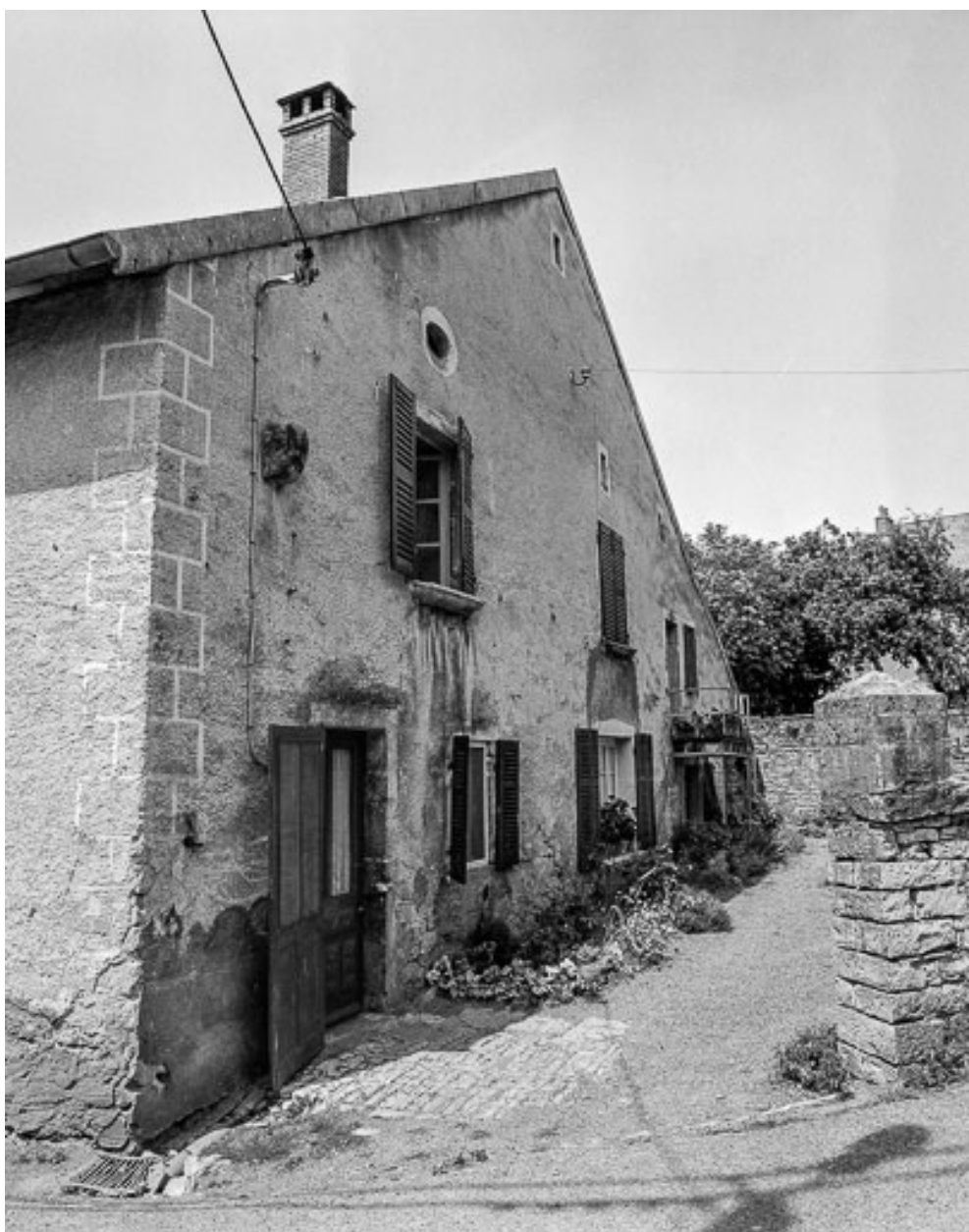
Maison située entre la rue de la Traverse et la ruelle des Escaliers : façade antérieure.
