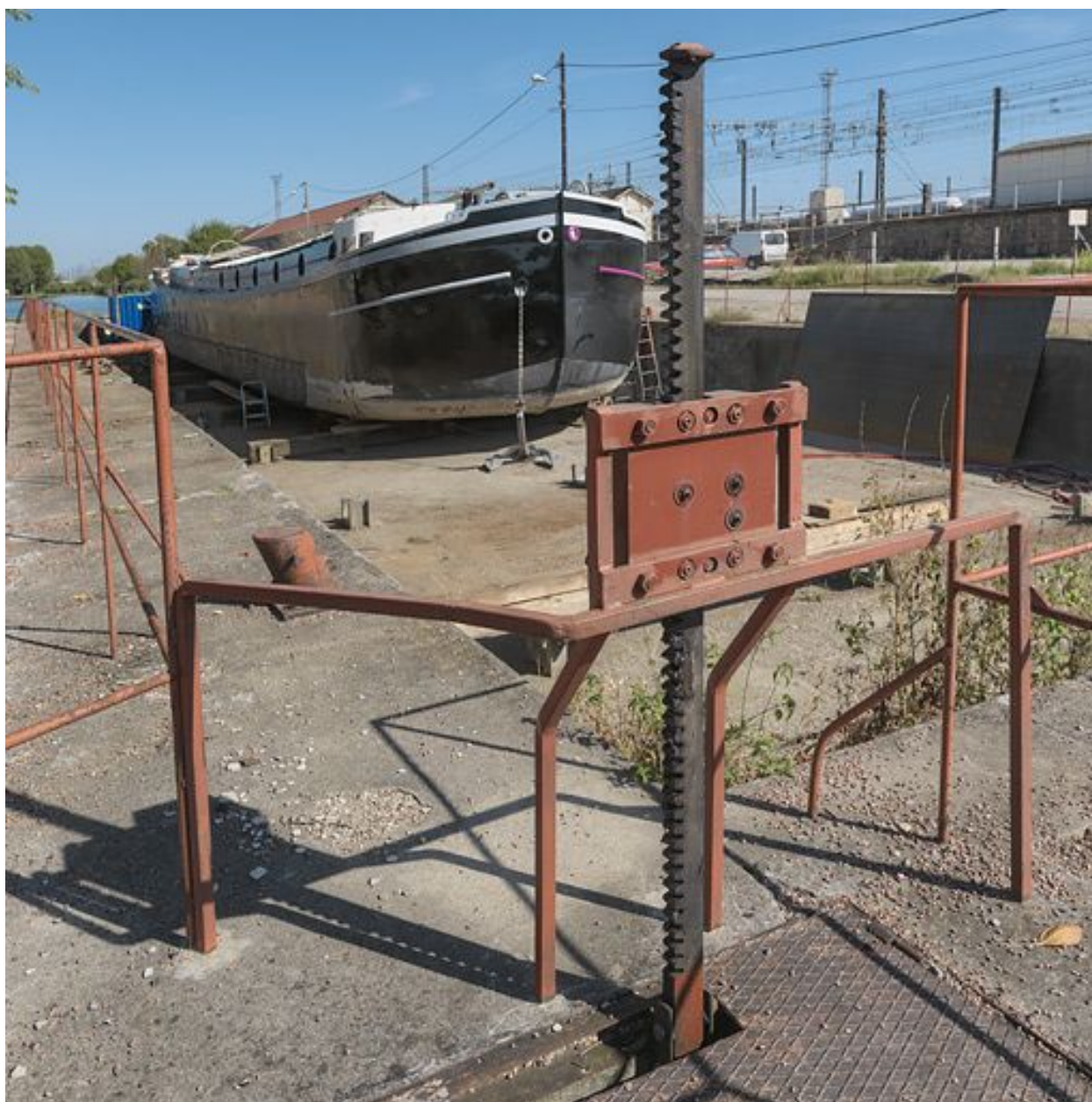
La cale sèche. Détail des vannes.
