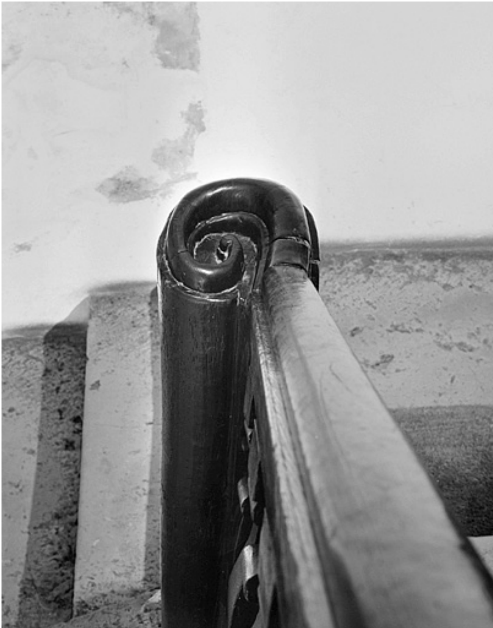
Détail du départ de la rampe d'appui.
