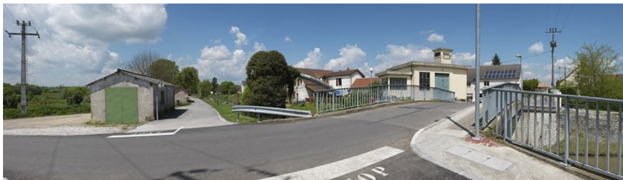
Vue d'ensemble du site avec le pont au premier plan.
