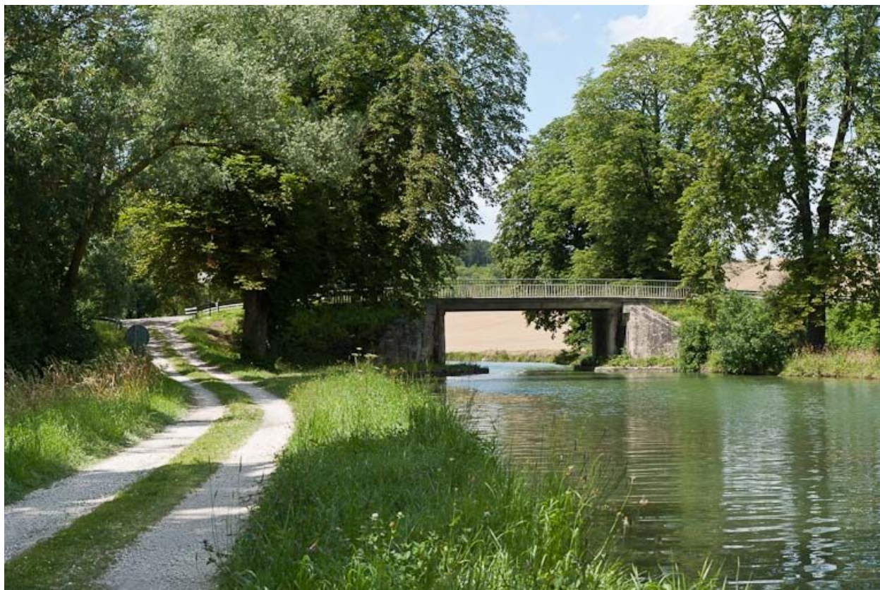
Vue du pont.
