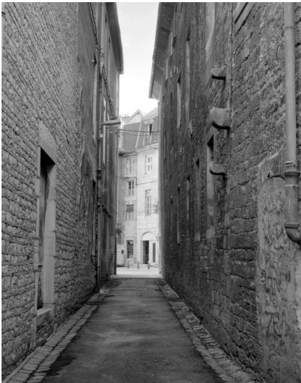
Façade latérale gauche : vue rapprochée.
