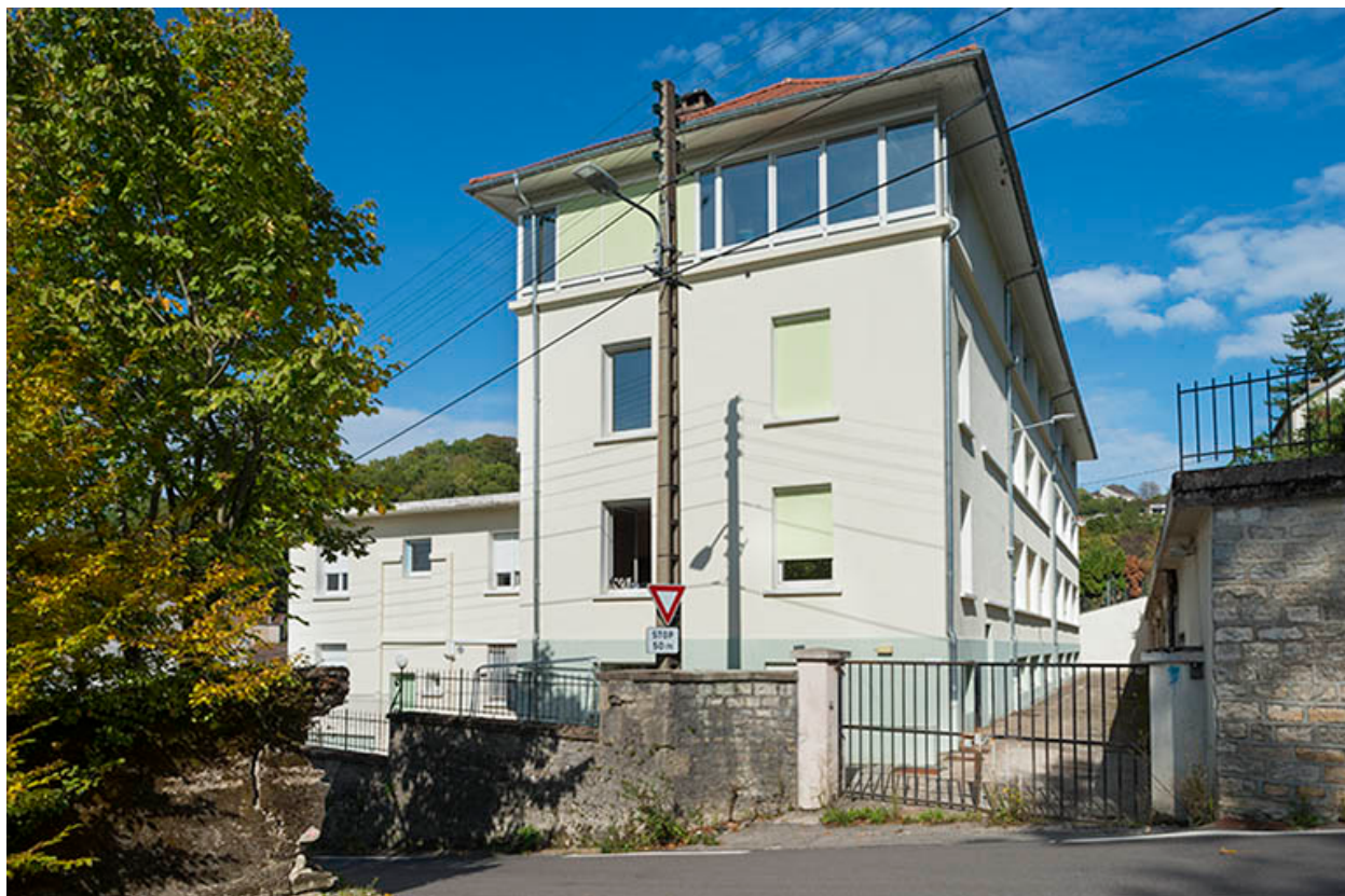
Pignon ouest et façade postérieure.
