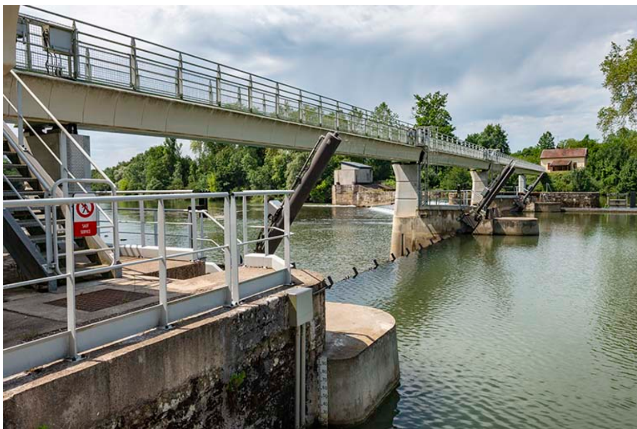
Le barrage à clapets.
