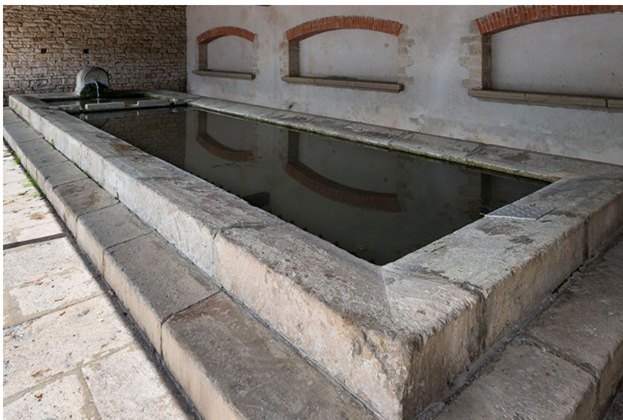
Bassin du lavoir.
