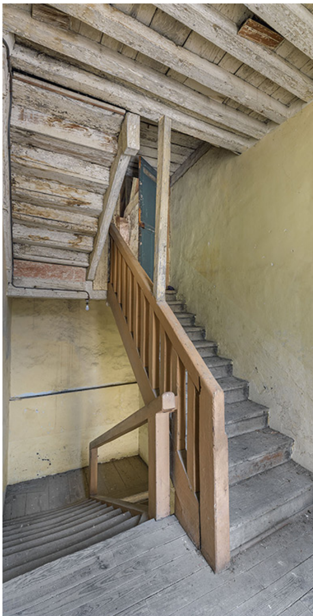
Caserne Vauban : cage d'escalier au 1er étage.
