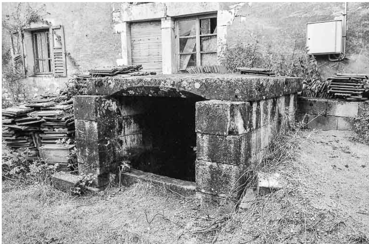
Détail de la fontaine.
