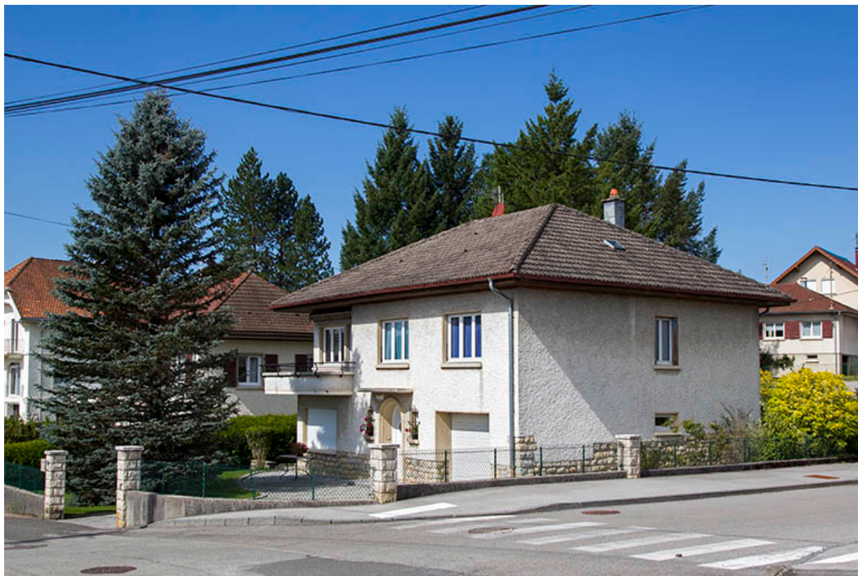
Façades antérieure et latérale droite.
