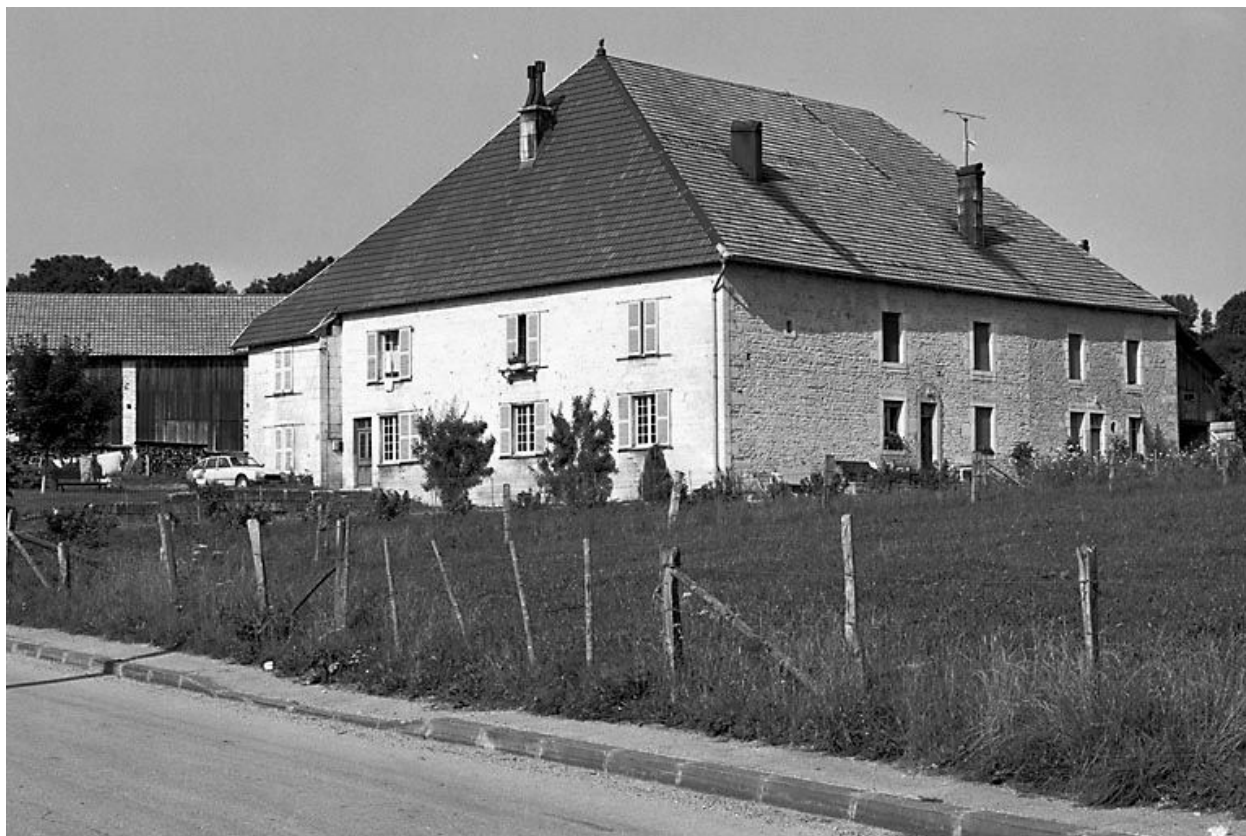
Ferme située rue du Château d'Eau.
