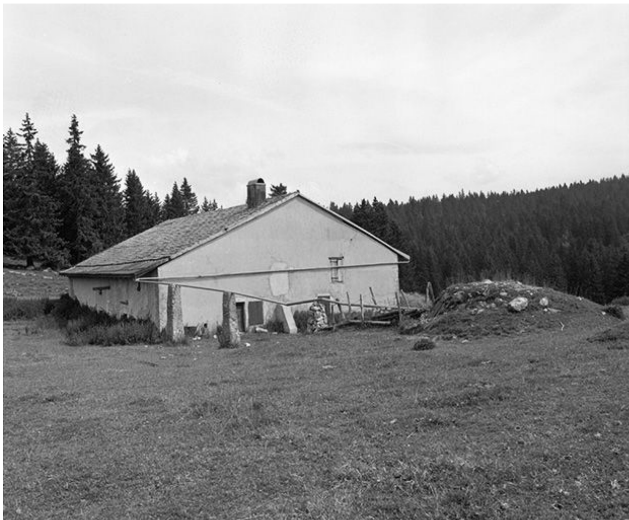
Façades postérieure et latérale gauche.
